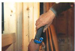
4 皮むき器で管端の被覆除去
