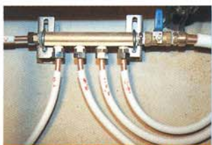
12 ヘッダーに接続完了 (給湯)
