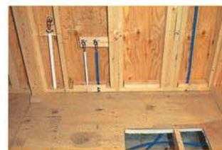
13 配管を終え機器への取付けを待つ銅配管
