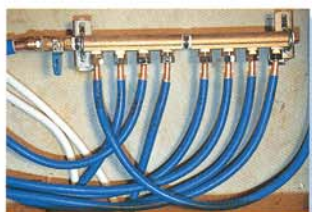
11 ヘッダーに接続完了 (給水)
