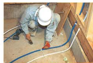
7 銅管を床に固定
