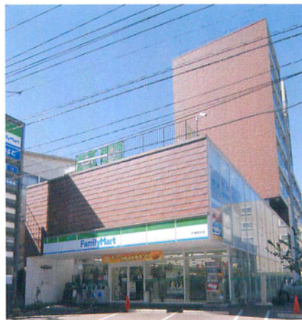
銅で覆われたビルの全景。竣工当初は金褐色に輝いていたが、現在は落ち着いた銅色に覆われている。
