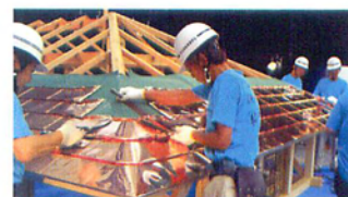
銅屋根施工の実演
