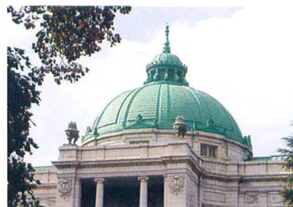
改修が完了したドーム屋根
