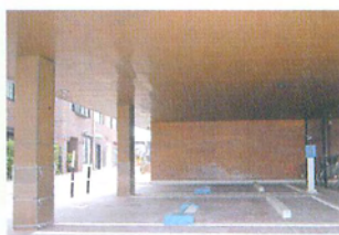
駐車場の壁面、柱に張られた銅板
