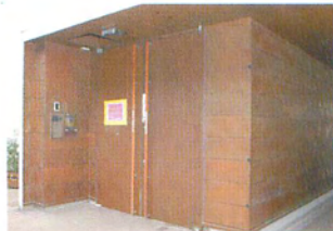
銅を使用したエントランス扉
