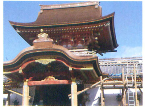
石清水八幡宮(写真は修造中)
