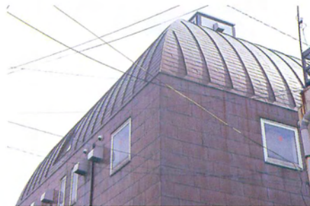
銅屋根・銅壁の様子
