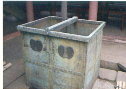
銅製雨水受水槽
