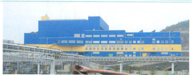
製錬所敷地内に建設された豊島廃棄物の処理施設「香川県直島環境センター中間処理施設」。豊島の廃棄物は輸送船(左)で運び込まれる
