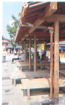
休憩所には雨が流れると音の出る銅製樋が…(タニタハウジング(株)提供)
