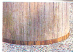
神宮内建造物の柱にはすべて保護用の銅板が巻かれている
