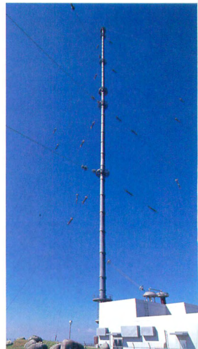
はがね山標準電波送信所 澄み切った青い空に地上高200mの傘型アンテナがのびる。ここから電波が発信されている
