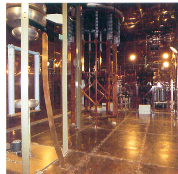
整合器室 ここでは送信機とアンテナの整合を図る。 床、天上、壁すべて銅でシールドされている
