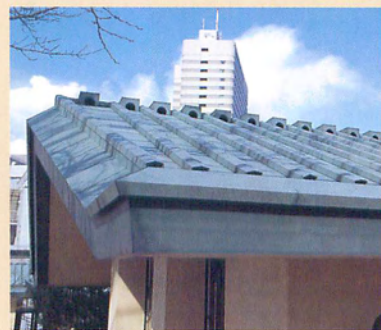
緑青加工された銅板葺きの屋根
