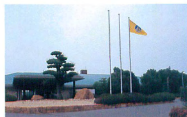
製錬所近くのゴルフ場(瀬戸大橋カントリークラブ)には銅屋根が使用されていた
