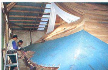
銅屋根への改修が進む鐘つき堂
