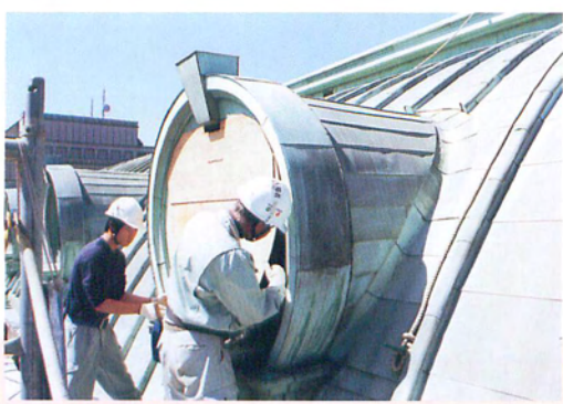
ドーマー窓部の調査
