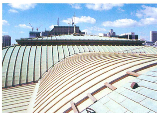
大屋根の修復
