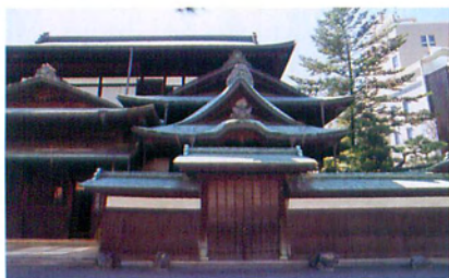
本館裏手の銅板屋根
