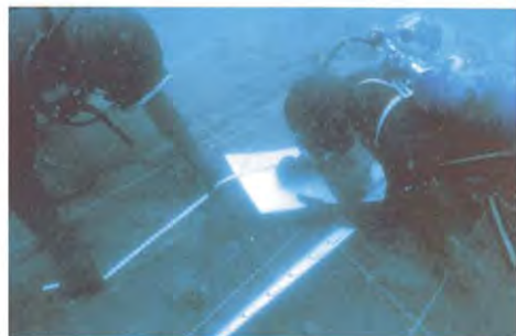
銅ネットの布設
