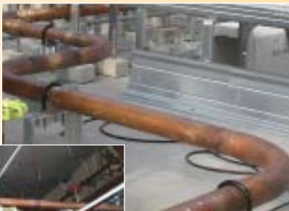
屋上機械ベンダー曲げ加工
