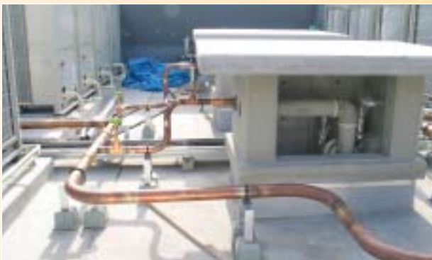
屋上気水分離器にいたる給湯用銅管(主管)
