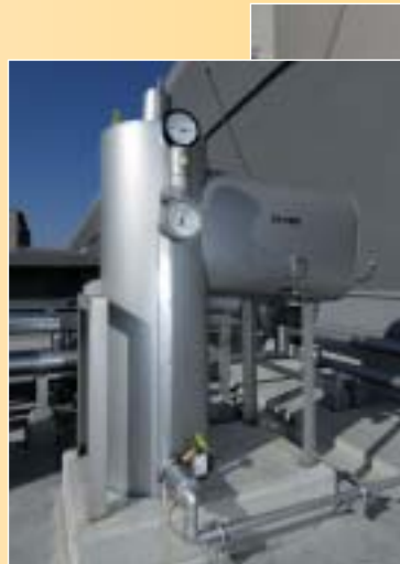
屋上気水分離器にいたる給湯用銅管(主管)
