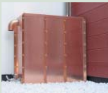
銅製雨水タンク
