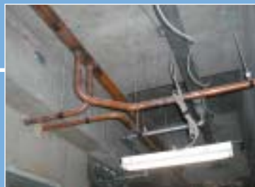
6階天井銅配管
