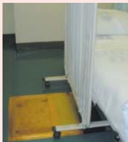
ベッド下の床に敷設された銅板
