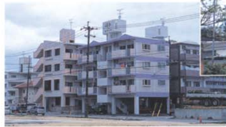
建物の屋上には必ず貯水タンクが
