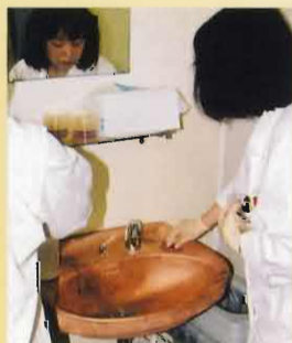
病室内の銅製洗面台
